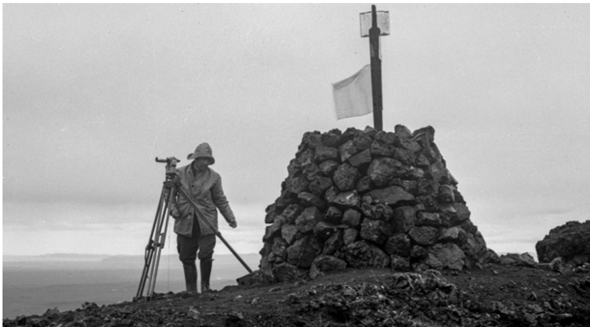
Varðan á Eilífi með merkispýtnni Það er greinilega ár en Mývetningar gáfu leiðangrinum þær iðulega til merkinga. T.v. við vörðuna stendur líklega Emschermann við theodolítinn (sjónaukann) sem notaður var til hæðar- og fjarlægðarmælinga. Ljós.: Tómas Tryggvason
