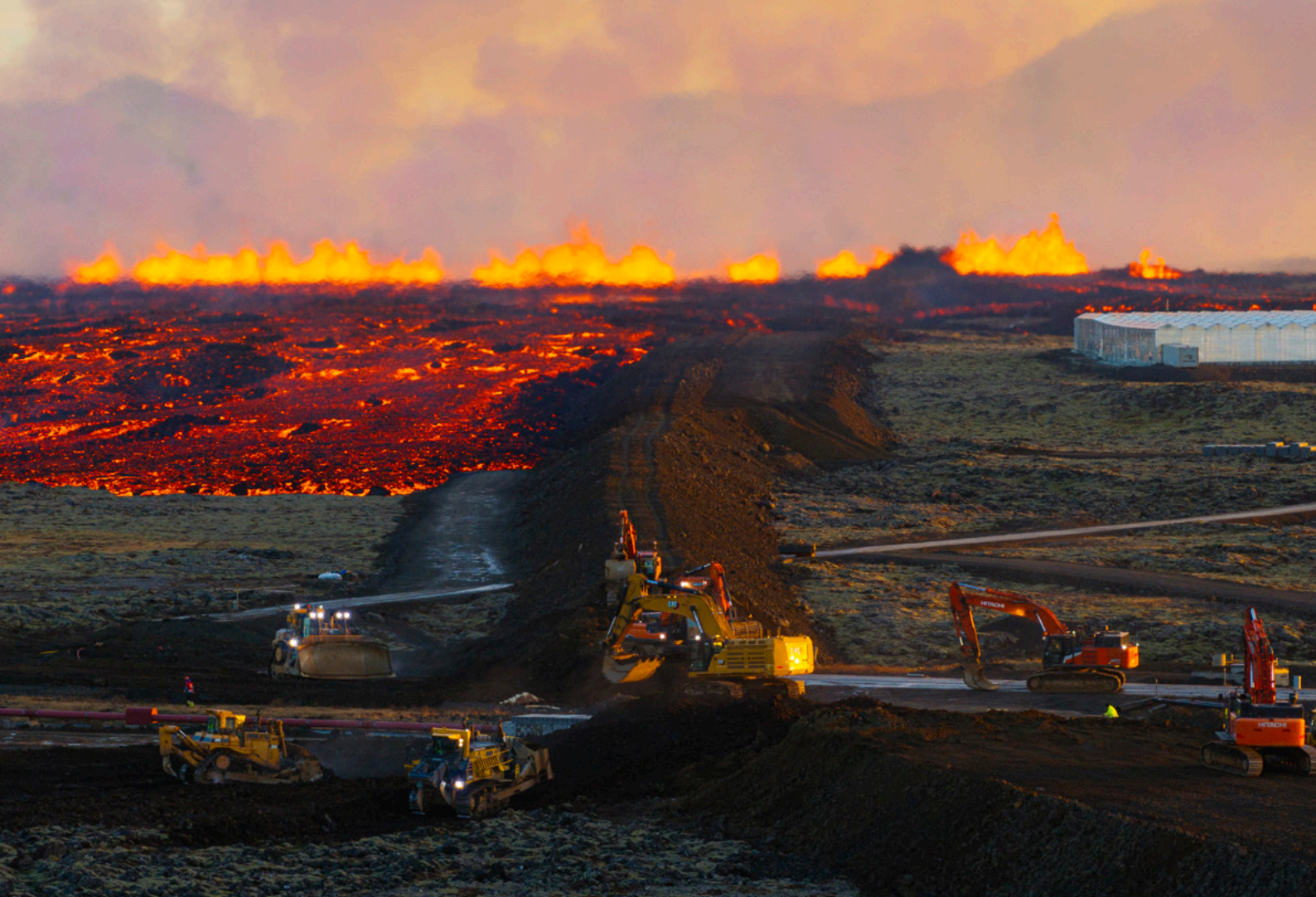
Varnargörðum lokað við krefjandi aðstæður við Grindavíkurveg áður en hraunflæmið nær að brjóta sér leið til Grindavíkur. – Protective barriers were closed under challenging conditions near Grindavíkurvegur before the lava flow could break its way into Grindavík. Ljósmynd: Gólli
