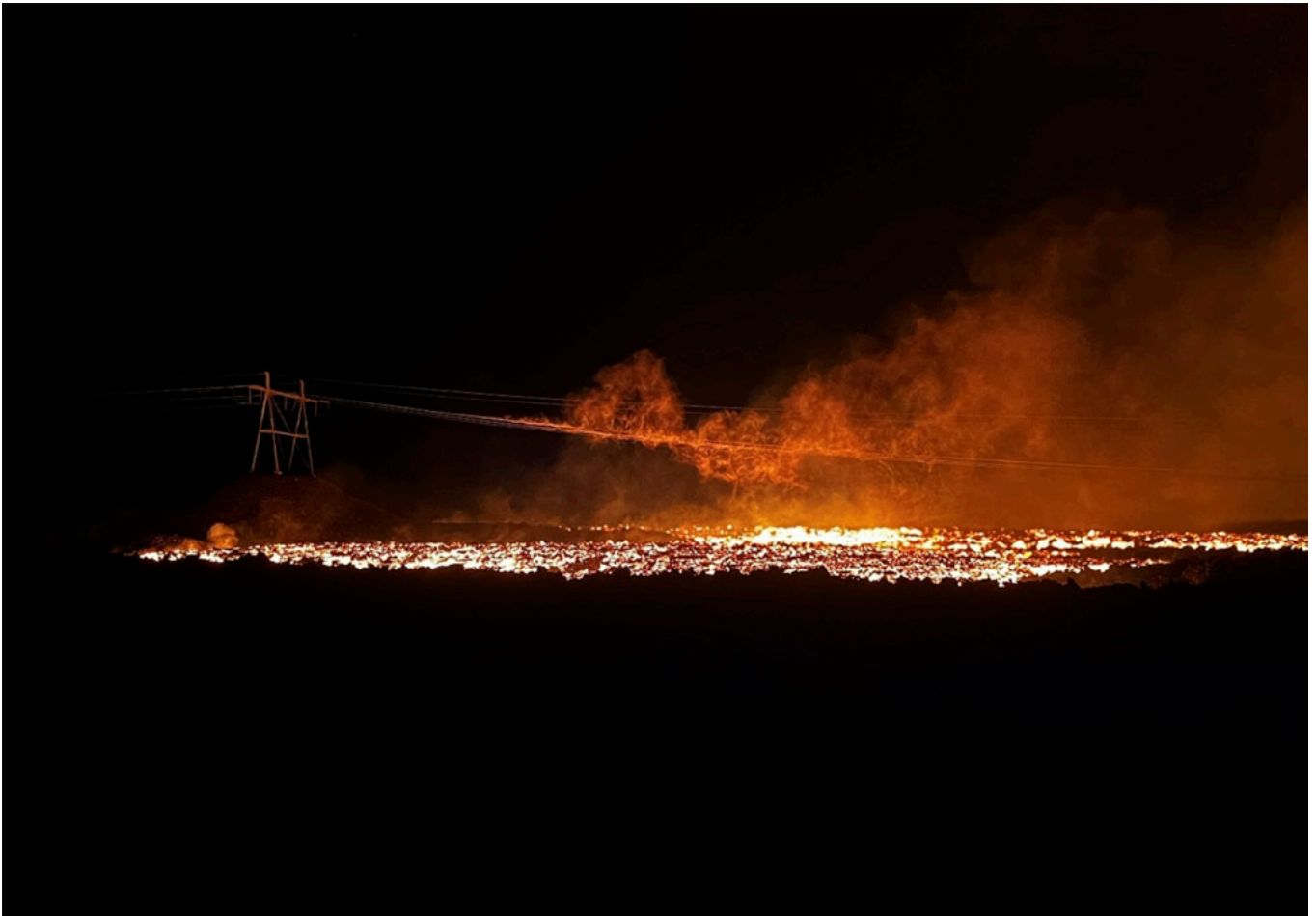
9. mynd. Hraun rann undir Svartsengislínu 1, sem seig ofan í hraunið og eyðilagðist. – Figure 9: Lava flowed under the Svartengislína 1 powerline, causing it to subside into the lava. Ljósmynd: Jón Haukur Steingrímsson
