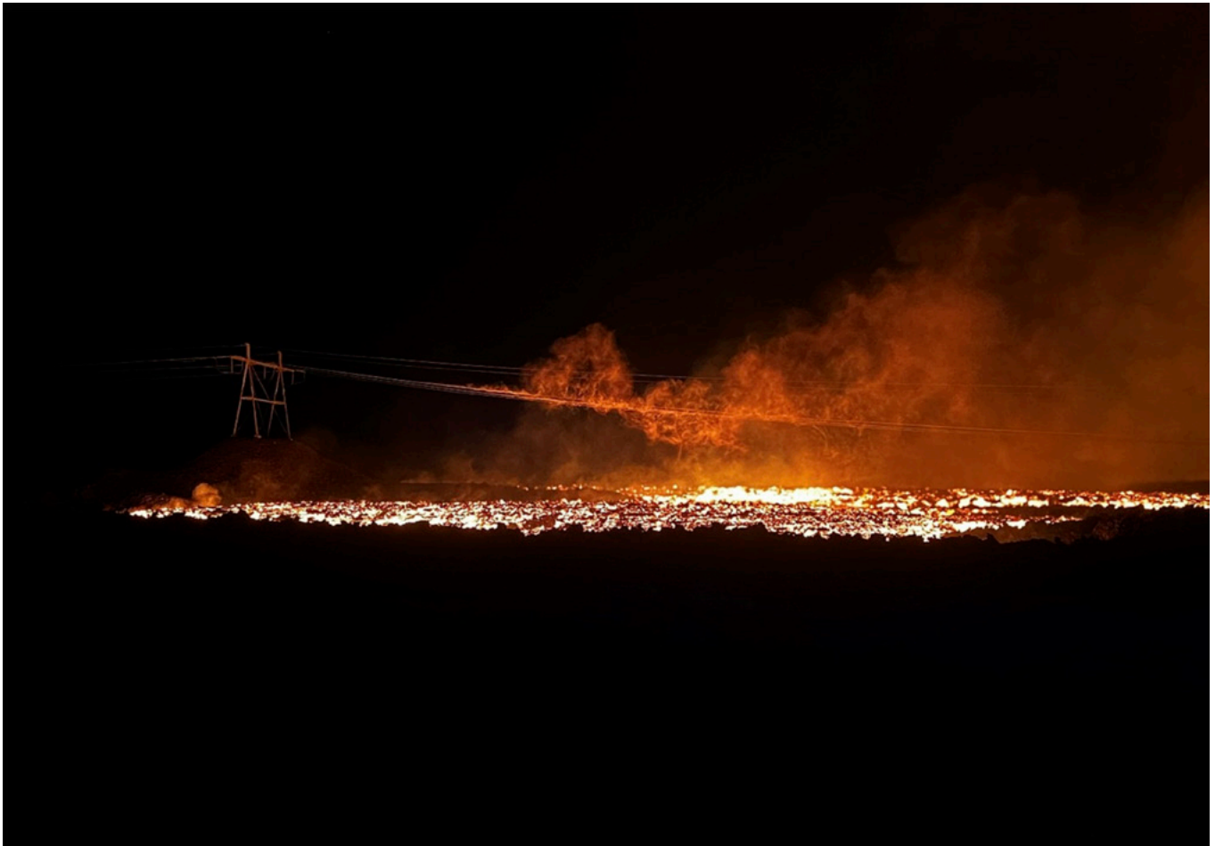
9. mynd. Hraun rann undir Svartsengislínu 1, sem seig ofan í hraunið og eyðilagðist. – Figure 9: Lava flowed under the Svartsengislína 1 powerline, causing it to subside into the lava. Ljósmynd: Jón Haukur Steingrímsson
