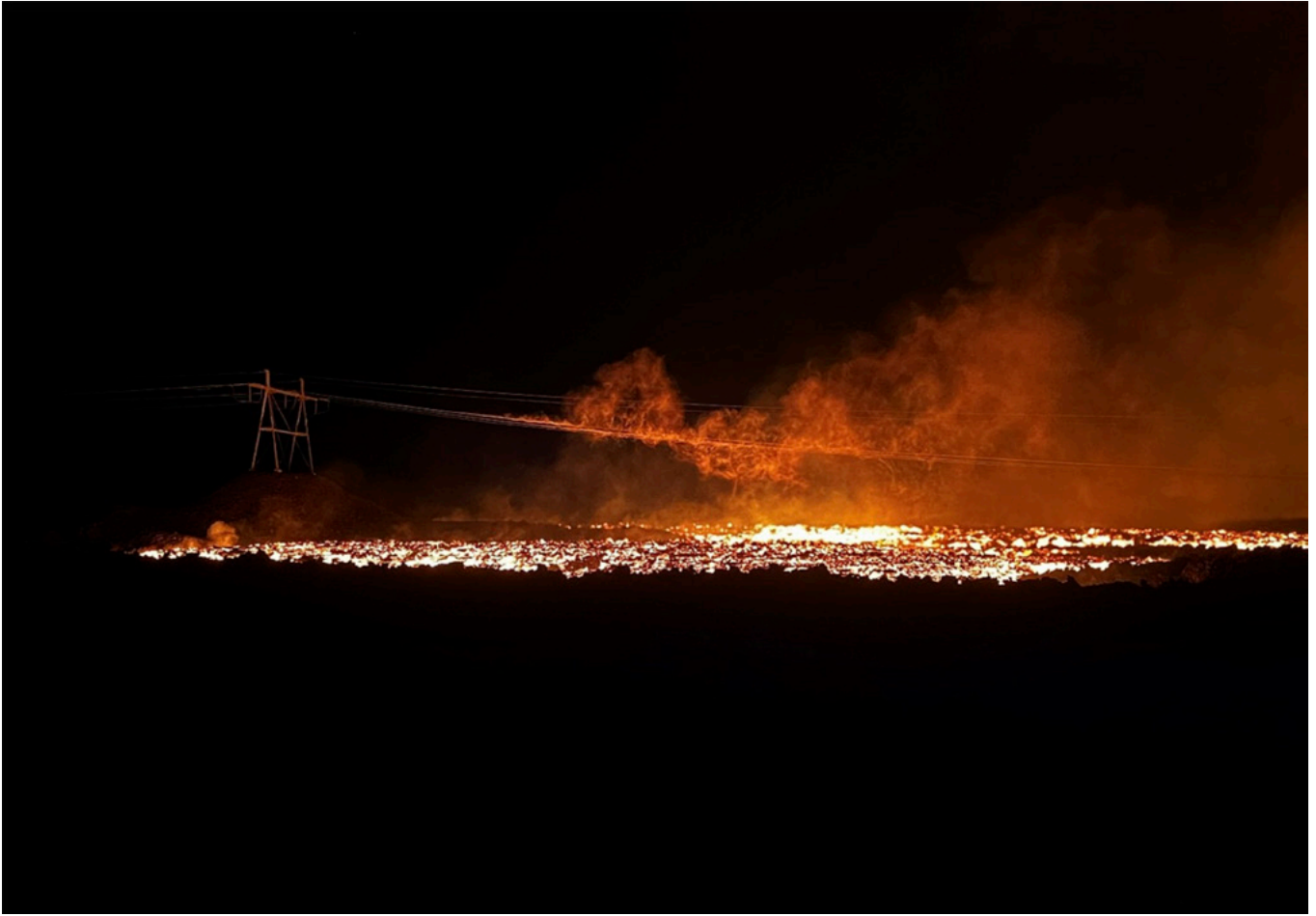
9. mynd. Hraun rann undir Svartsengislínu 1, sem seig ofan í hraunið og eyðilagðist. – Figure 9: Lava flowed under the Svartengislína 1 powerline, causing it to subside into the lava. Ljósmynd./Photo: Jón Haukur Steingrímsson
